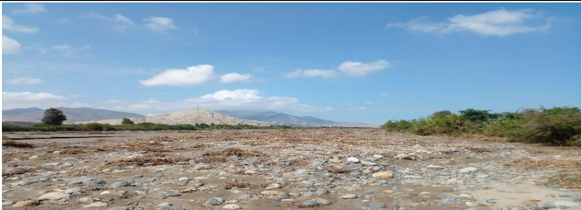
FIGURA N°1 TRAMO DEL CAUCE DEL RIO NEPEÑA COLMATADO, UNA ALTURA APROXIMADAMENTE DE 0.70M.
