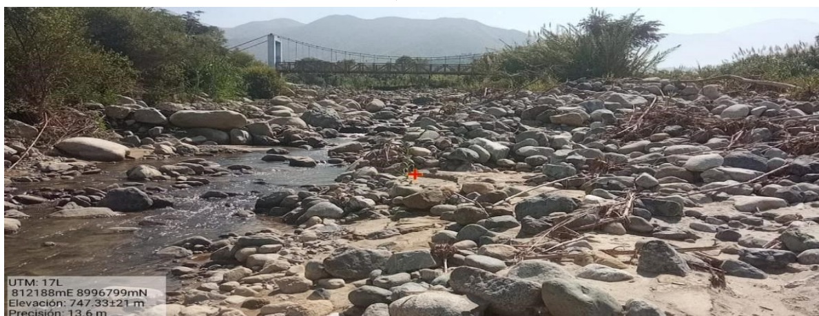
FIGURA N°02.- EN LA FOTOGRAFIA EL DIQUE DE LA MARGEN DDERECHA Y IZQUEIRDA HAN SIDO EROSIONADOS POR EL AUMENTO DEL CAUDAL DEL RIO NEPEÑA
